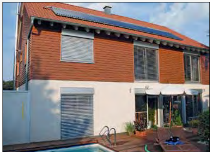
Enfamiliehus med BIOCAT KS 3000 kalkbeskyttelses anlæg
