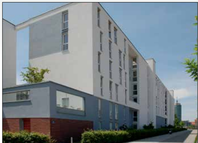
Boligbyggeri i Max-Friedländer-Bogen i München med BIOCAT KS 14000 KS 14000, designet til 110 boliger
